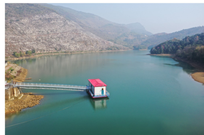
咸安区花纹水厂取水浮船泵站
