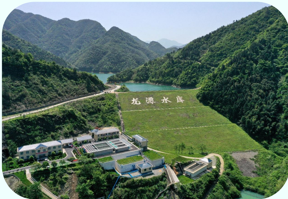
通城县龙潭水厂
